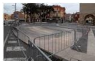
RIMOZIONE AREA DI CANTIERE
